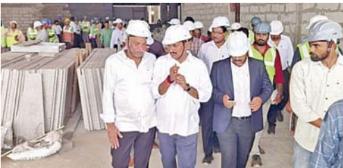
04 జివిఆర్ యం 12 : విమానాశ్రయంలో టెర్రినల్ నిర్మాణ పనులు పరిశీలిస్తున్న యంపి కేశినేని చిన్ని ఎమ్మెల్యే వెంకట్రామ్
